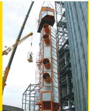
Модульная идея MEGA позволяет производить монтаж надежно и быстро, производя большую часть работ по сборке модулей на земле. По окончании сборочных работ их поднимают и устанавливают с помощью подъемного крана, очень сильно сокращая работы на высоте. Все инспекторы и рабочие для выполнения этих работ проходят обучение и подготовку на фабрике.
